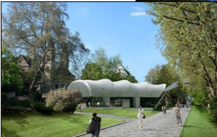
3S-Bahn Koblenz Talstation
